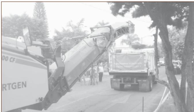
Figura 1. Máquina de Fresado removiendo una capa existente de pavimento asfáltico.
